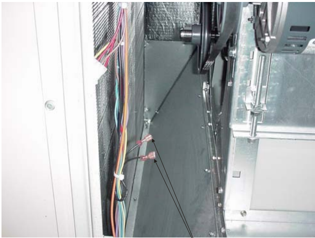
DISCHARGE AIR SENSOR WIRES
